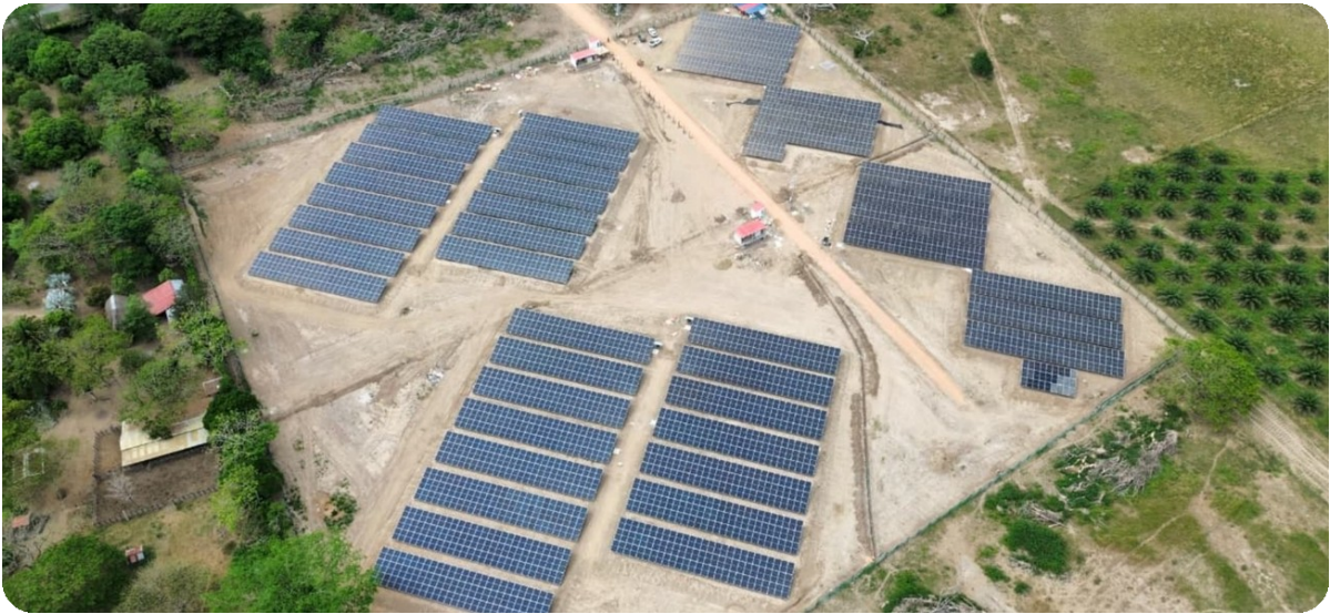
Campo solar en construcción — Los Pisingos
